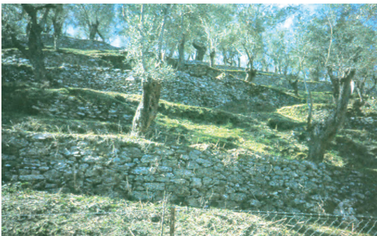
Εικόνα 15 Ελαιώνας σε αναβαθμίδες με τοίχο αντιστήριξης (ξηρολιθιά).
