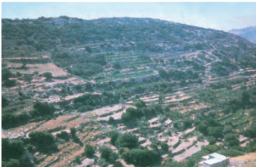
Εικόνα 16 Συνδυασμός αναβαθμίδων με τοίχους αντιστήριξης και επιχωματώσεις.
